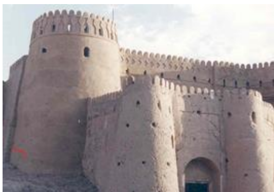
شکل ۵: آثار هسته‌ی نخستین برج‌های مکعب ورودی اول در پس لایه‌های الحاقی؛ ت. راست، برج شرقی. دید از جنوب شرق. ت. چپ، برج غربی، دید از جنوب غربی، پیش از زلزله (مأخذ: بایگانی پایگاه میراث جهانی بوم و منظر فرهنگی آن).
