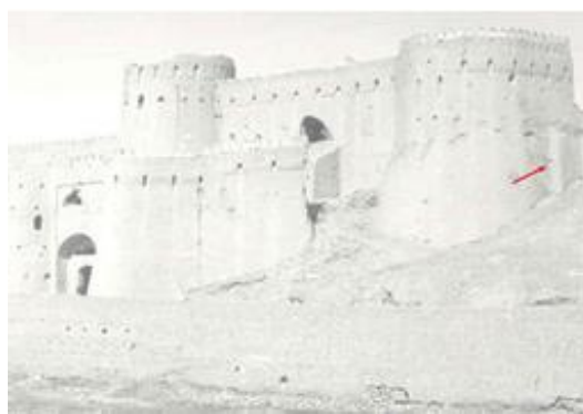
شکل ۵: آثار هسته‌ی نخستین برج‌های مکعب ورودی اول در پس لایه‌های الحاقی؛ ت. راست، برج شرقی. دید از جنوب شرق. ت. چپ، برج غربی، دید از جنوب غربی، پیش از زلزله (مأخذ: بایگانی پایگاه میراث جهانی بوم و منظر فرهنگی آن).
