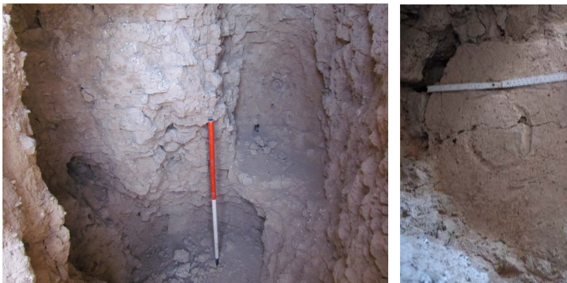
تصویر ۵- تخریب برج جنوب‌شرقی ارگ (چپ) و برونزد علامت نقر شده توسط خشت‌زن بر سطح خشت (راست) (تصویر از نگارنده) Figures 5- Destruction of the southeast tower of the citadel(right) and the outcrop of the gilded mark by a bricklayer on the surface of themud brick (left). (image by the author).
