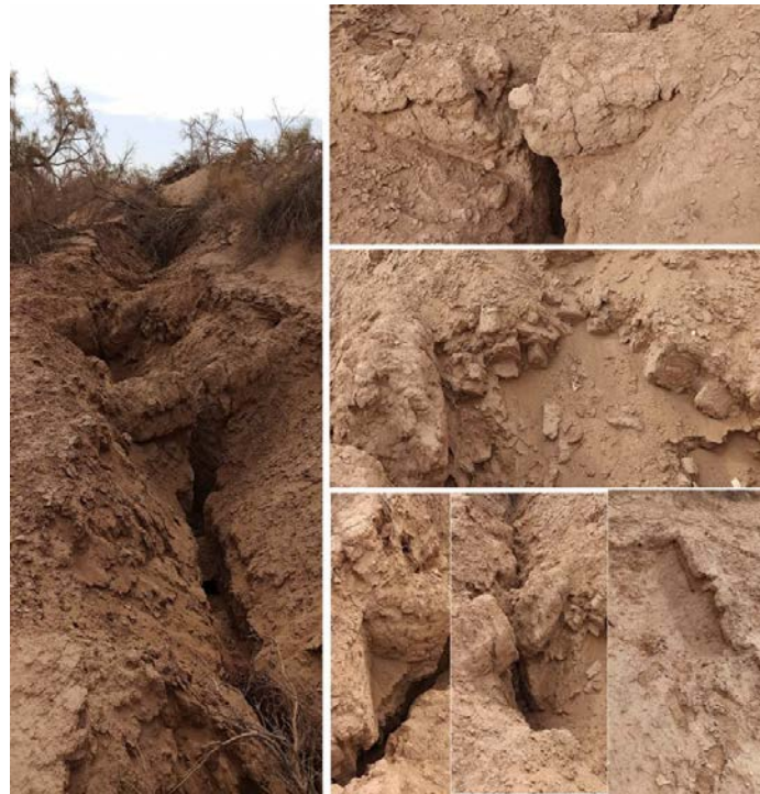
شکل ۵: رانش زمین و ایجاد شکاف در آن منجر به هویدا شدن بخشی از معماری مدفون در محوطه اِسْفَنجِرد شده Fig 5. Landslide and creating a ground crack, led to the uncovering of a part of the buried architecture in Esfanjerd.
