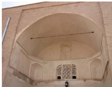
تصویر ۴: ایوان ورودی ضلع غربی جزئیات پنجره مشبک و طاق‌نماهای کم‌عمق داخل ایوان (نگارندگان، ۱۳۹۶)
