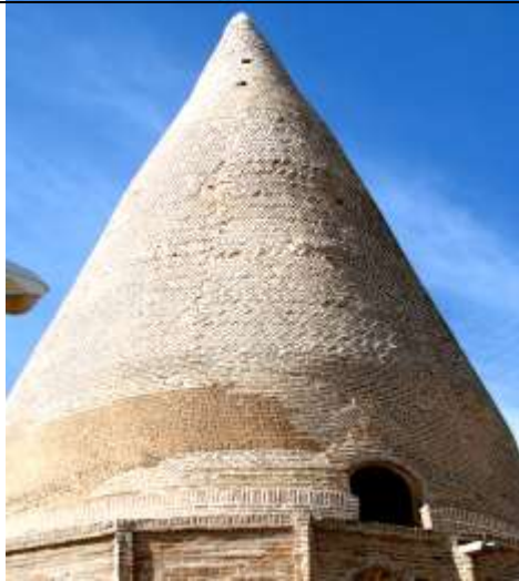
تصویر ۸: گنبد مخروطی بنا و شیوه آجرکاری آن (نگارندگان، ۱۳۹۲)
