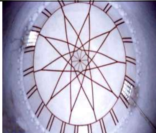
تصویر ۱۲: تزیینات گنبد زیرین بنا (نگارندگان، ۱۳۹۲) Figure 13: Decorations of the inner dome of the building (Authors, 2013)
