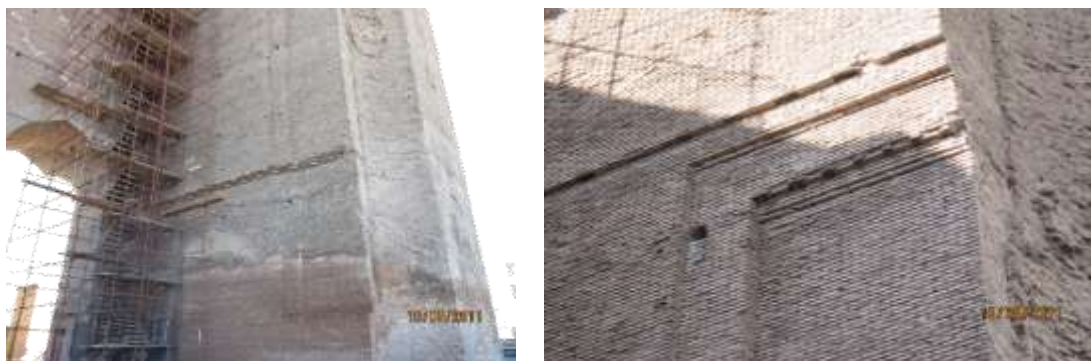
تصویر ۷: راست: بخشی از کادرهای تزئینی کامل نشده بر روی بدنه‌ی U شکل. چپ: فرورفتگی‌های روی پایه‌ها که احتمالاً با اهداف اتصال بنای جدید به بنای بخش شمالی مرتبط بوده است (نگارندگان).
