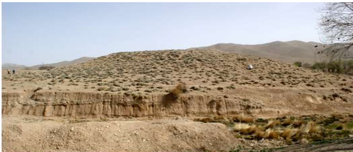
تصویر ۳: نمای کلی تنب قلعه مشرف به رودخانه بوانات (دید از جنوب)
