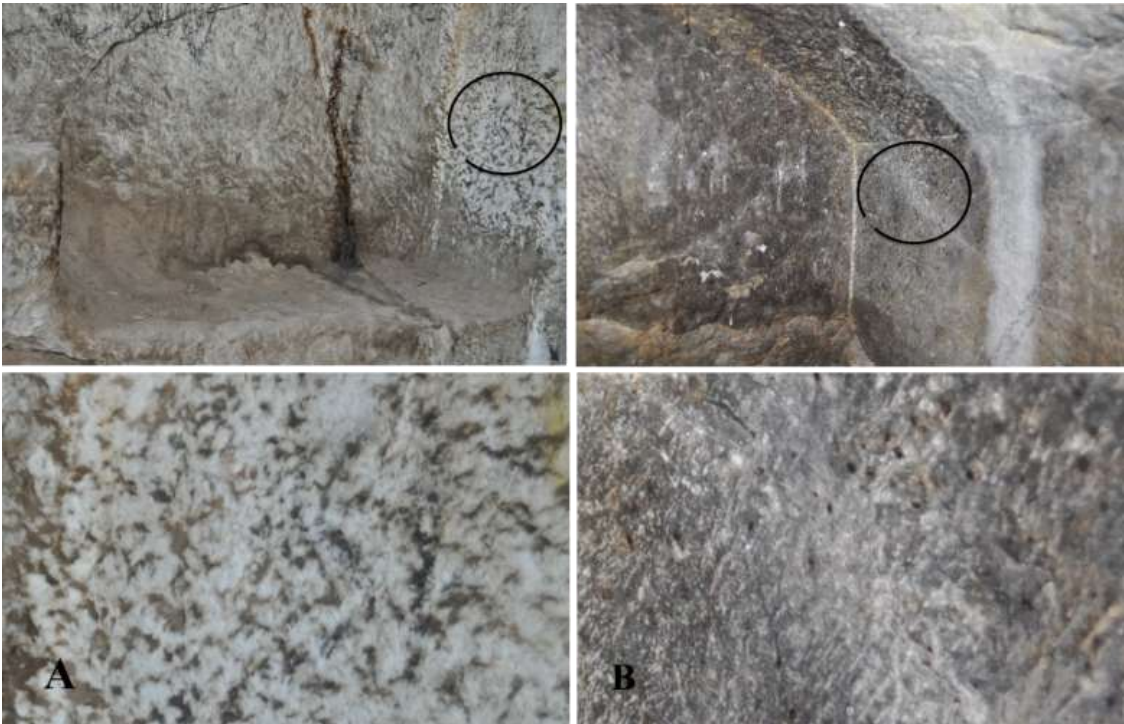
تصویر ۲۰: دو نمونه از دو گونه تکنیک تراش سنگ در گوردخمه صحنه. اثرات صیقل بر دیواره کناره چاله تابوت برداشته‌شده (A) و اثر تراش با قلمی با دندان‌ریز بر دیواره و کنج دهلیز پایین (B). منبع: (نگارنده)
