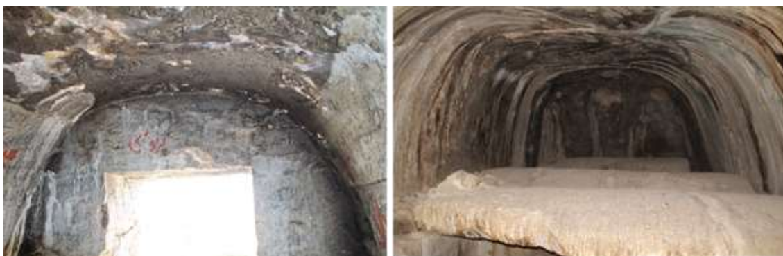
تصویر ۲۲: تصویر چپ: فوس و تاق گهواره‌ای دهلیز فوقانی گوردخمه صحنه. تصویر راست: نمایی از دهلیز آرامگاه خشایارشا با تاقی گهواره‌ای. منبع: نگارنده، آبان ۹۱، خرداد ۹۲
