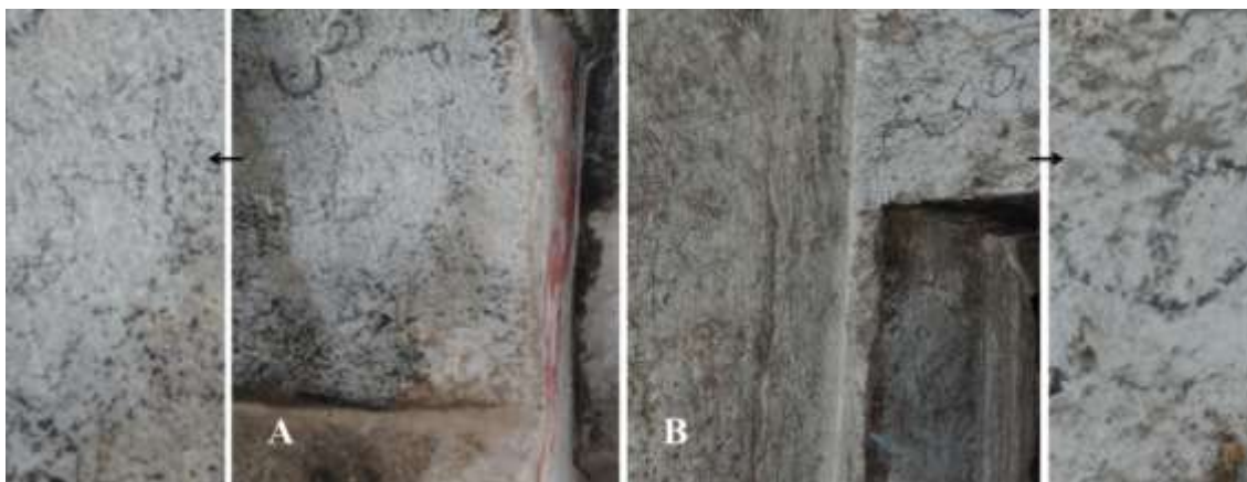
تصویر ۲۱: تکنیک تراش سنگ و اثرات صیقل بر سردر و کناره داخلی درگاه دهلیز پایین (B) اثر صیقل سنگ بر دیواره‌های اتاق بالایی (A). منبع: نگارنده
