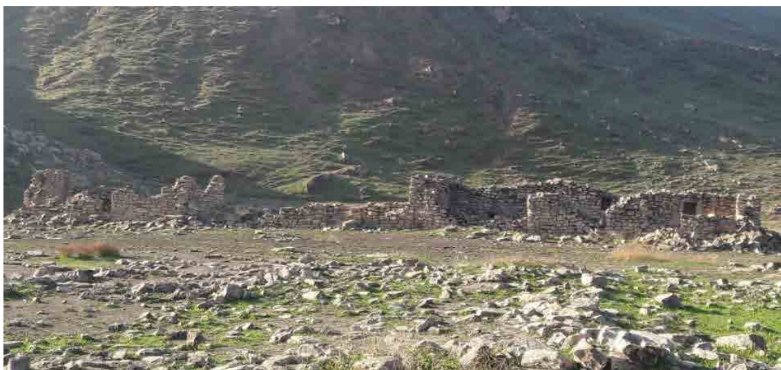
تصویر ۵: نمای کلی از سازه معماری دوره متأخر محوطه شماره ۳۳ سد چم شیر - دید از شمال شرق (نگارندگان، ۱۴۰۱).
