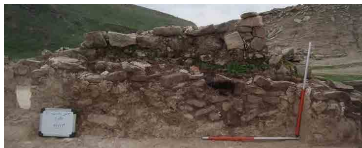
تصویر ۱۵: پایه‌های ضلع جنوب غربی فضای معماری که اختلاف ارتفاع آن با دیوار اصلی مشخص است (نگارندگان، ۱۴۰۱). Fig. 15: The foundations of the southwest side of the architectural space, with a clear height difference from the main wall (Authors, 2022).
