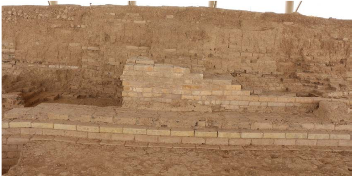
شکل ۳۱: امتداد آجرها در زیر هسته خشتی دیوار شرقی (عکس از نمای شرقی تالار)، (هیأت مشترک ایران-ایتالیا).
